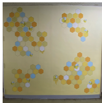
学生ロッカー前通路、 壁面の改装
