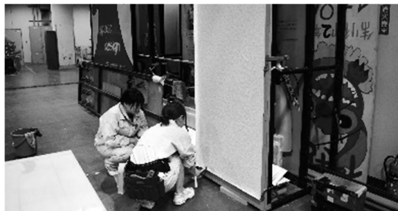
図2 内装施工実習の様子
