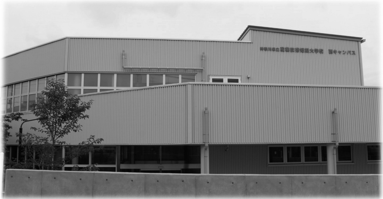
令和5年2月に竣工した西キャンパス
