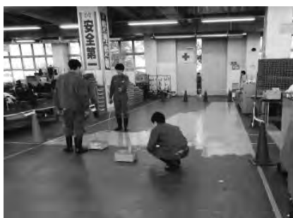
(b)床面塗装作業 図1 実習場の床面整備
