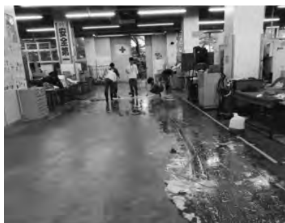
(a)油分除去作業
