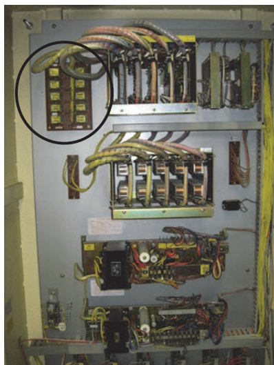
図2 自動火災警報受信装置の内部写真
