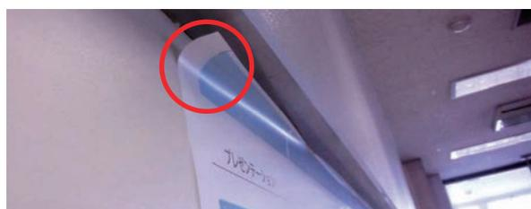
図6 壁面施工の不具合(剥がれ)
